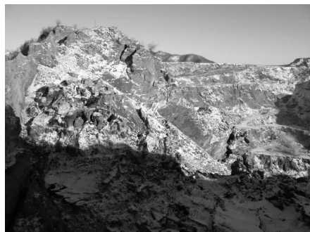
图 4 小汪沟铁矿露天滑落状态
